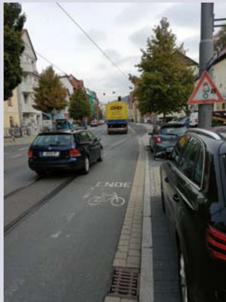
Suboptimaler Fahrradweg. Die Gefährdungen kommen von rechts und links. Kreuzende Schienen und das Ende des Fahrradstreifens sind weitere Gefahrenpotentiale.
